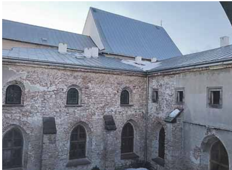
Dach klasztoru i kościoła w Chęcinach po remoncie
